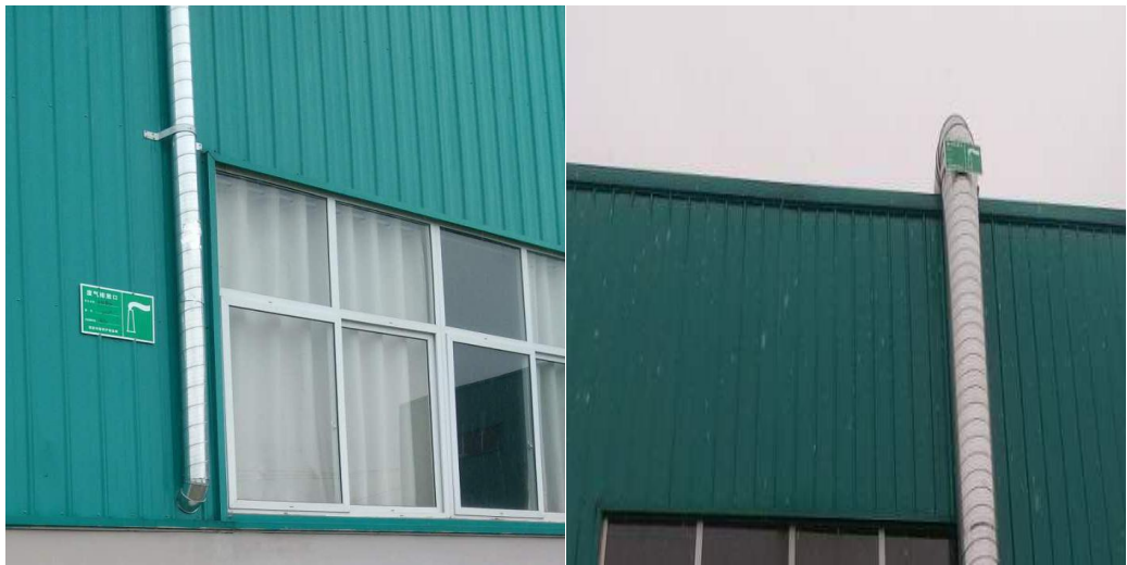
2#排气筒标识牌 1#排气筒标识牌
