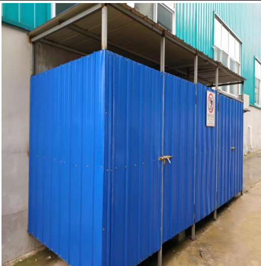
空压机设备间
