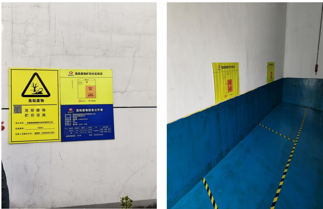
危废暂存间图片
